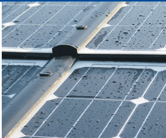
Fig. 1 - Detail of BIPV monocrystalline modules in the 5 kWp PV plant in Verona (Photo: GSE Gestore dei Servizi Energetici - www.gse.it ).
