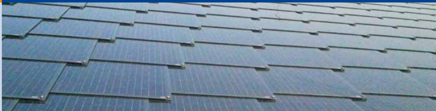
Fig. 3 - 12 kWp PV plant at Borgoricco (PD), using SAINT-GOBAIN SOLAR rigid modules on tiles (SI crystalline cells) (Photo: GSE, Gestore del Sistema Elettrico).
