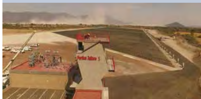
Fig. 3 - Solar plant Jalisco I; Zacoalco de Torres, Jalisco. Mexico; 8,0 MW (Photo: https://www.fortius.com.mx/node/50 ).
